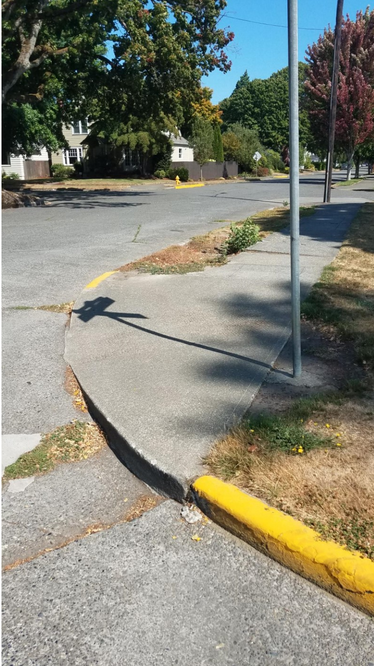
Photo # 13: SE ADA ramp
