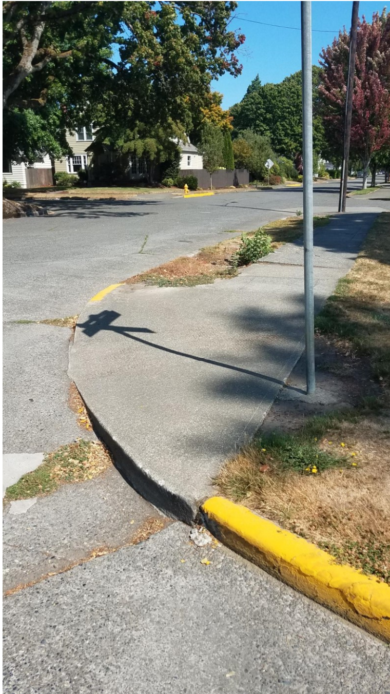
Photo # 13: SE ADA ramp
